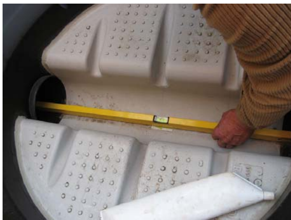
Slika 3 i 4: Kontrola položaja odvoda
