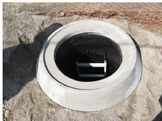
Slika 9 i 10: Postavljanje betonskog prstena za prihvatanje opterećenja
