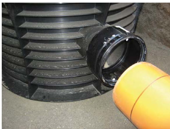
Slika 5 i 6: Izvođenje spoja šahta sa PVC cijevima
