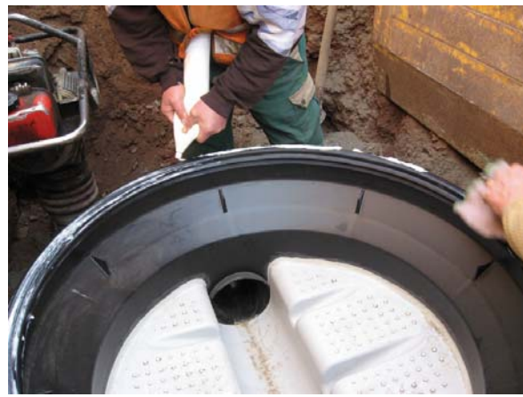
Slika 7 i 8: Postavljanje dihtunga na spoju dva elementa šahta
