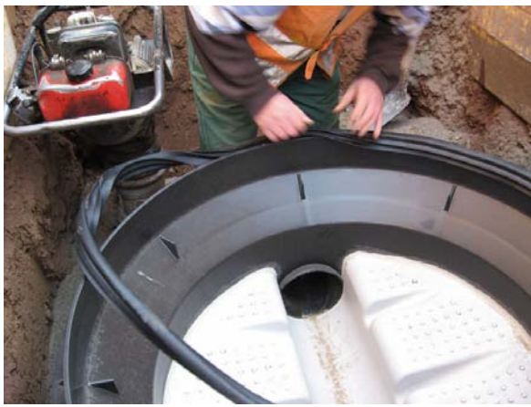
Slika 7 i 8: Postavljanje dihtunga na spoju dva elementa šahta
