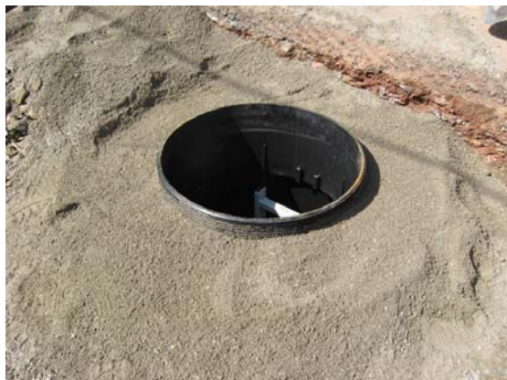
Slika 9 i 10: Postavljanje betonskog prstena za prihvatanje opterećenja
