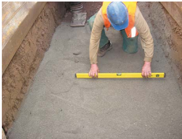
Slika 1 i 2: Priprema podloge za polaganje šahtova
