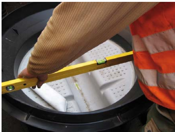
Slika 3 i 4: Kontrola položaja odvoda
