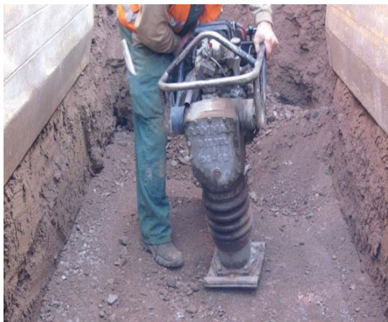
Slika 1 i 2: Priprema podloge za polaganje šahtova
