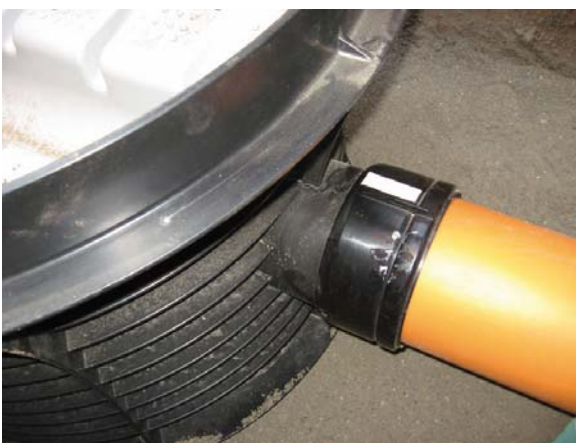
Slika 5 i 6: Izvođenje spoja šahta sa PVC cijevima
